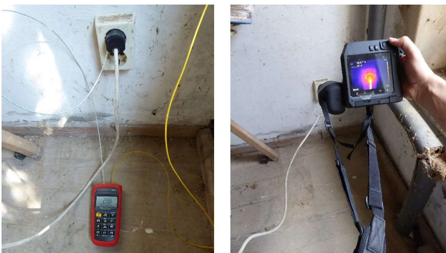
Abbildung 8: Vorortmessungen einer Steckdose mit Temperatursensor zum Temperaturverlauf und zur Kontrolle mit Thermographiekamera in EFH bei Pasewalk
